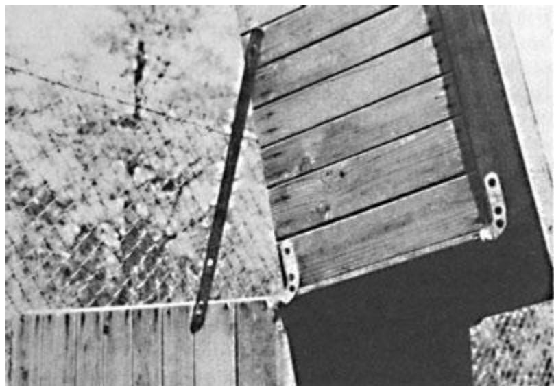
Обеспечение устойчивости магазинной подставки в откинутом положении при помощи металлической соединяющей полосы
